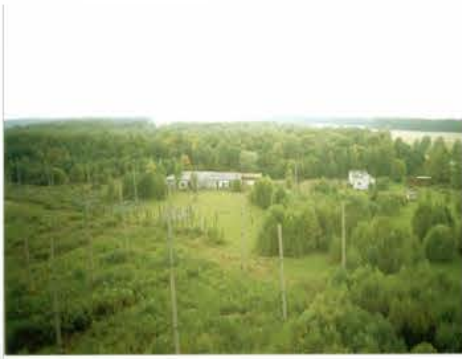
Стенд «СУРА». Корпус мощных передатчиков (слева), лабораторный корпус (справа), часть приемопередающей антенны стенда (на переднем плане).
